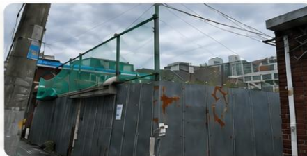
철거·정비 진행 펜스 설치 후 단계적 철거
